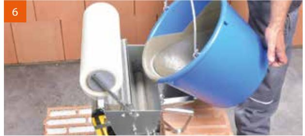
6 Befüllen der V.Plus®-Walze mit Dünnbettmörtel.
