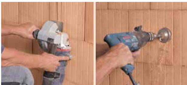
Schlitzte und Kronenbohrung für Elektrodozen
