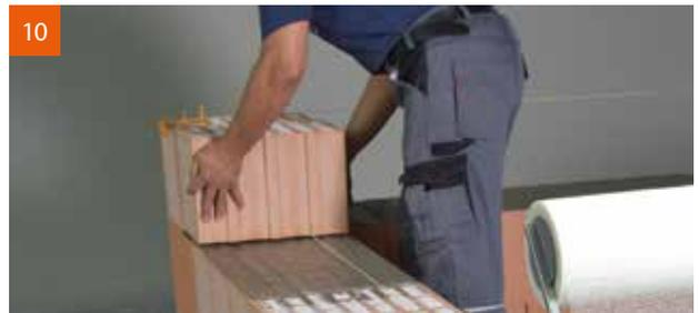
10 Einfaches knirsches Versetzen des Planziegels.
