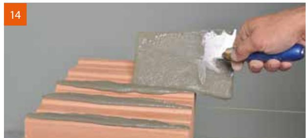
14 Eckanschluss: Mörtelauftrag auf die Verzahnung.
