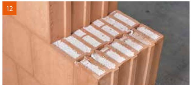
12 Der Ausgleichsziegel ist wärmebrückenfrei versetzt.
