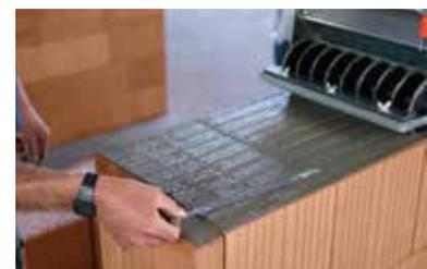
Ggf. zusätzliche Lagesicherung mit Flachstahllanker.
