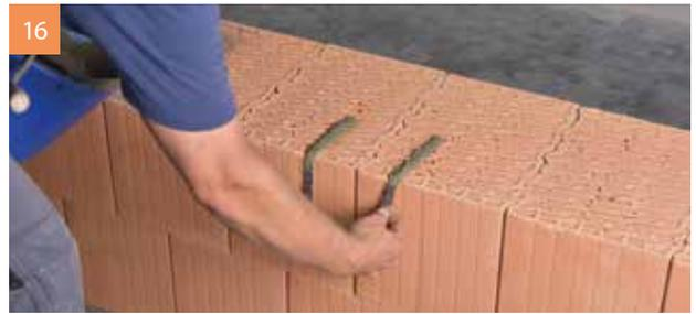
16 Einsetzen der in Dünnbettmörtel eingetauchten Flachstahlanker. Um Verletzungen vorzubeugen, werden die Anker umgebogen eingesetzt.
