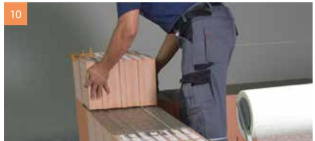
10 Einfaches knirsches Versetzen des Planziegels.
