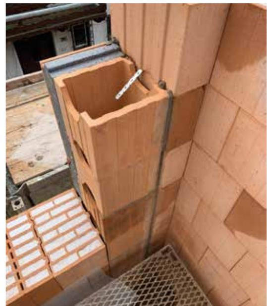
POROTON®-SDS als Eckstütze im Mauerwerk
