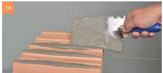
14 Eckanschluss: Mörtelauftrag auf die Verzahnung.
