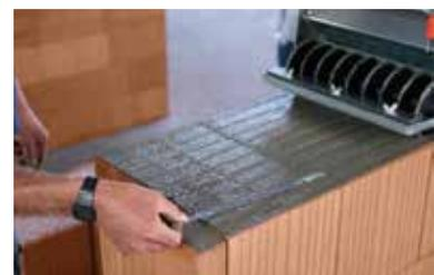
Ggf. zusätzliche Lagesicherung mit Flachstahllanker.
