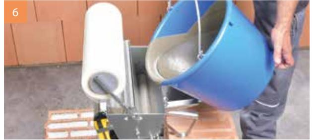
6 Befüllen der V.Plus®-Walze mit Dünnbettmörtel.
