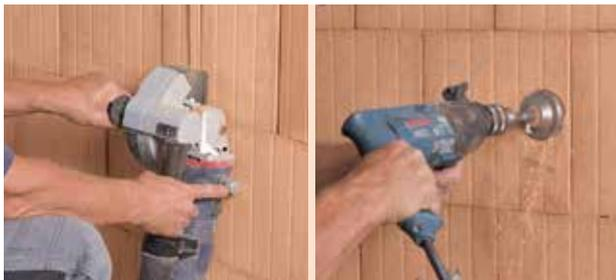
Schlitz und Kronenbohrung für Elektrodozen
