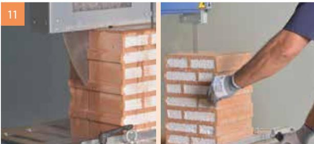
11 Ausgleichsziegel mit der Nass- oder Trockensäge schneiden.
