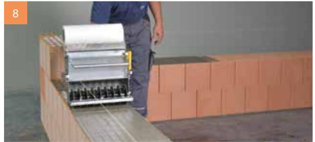
8 Walzen im Schritttempo und Versetzen gleichzeitig.
