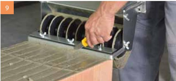
9 Abschneiden des V.Plus®-Glasfilamentgewebes mit Hilfe der Abschnittleiste und einem Teppichmesser.
