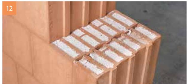
12 Der Ausgleichsziegel ist wärmebrückenfrei versetzt.
