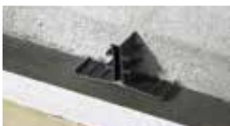
Schlüter-DILEX-EP ist ein Bewegungsfugenprofil für die Verarbeitung in schwimmenden oder Verbund-Estrichen. Die Seitenteile bestehen aus Hart-PVC mit einer unteren und oberen Bewegungszone aus grauem Weich-Kunststoff. (Produktdatenblatt 4.5)
