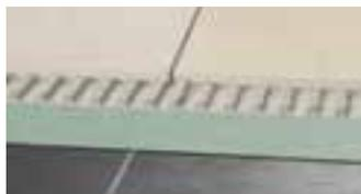
Schlüter-REFLEECE ist ein Vlies aus recyceltem PET mit einer rückseitig aufgetragenen Haftbeschichtung. Es eignet sich zur Herstellung wieder aufnehmbarer Bodenbeläge aus Fliesen und Naturstein. Die selbsthaftende Rückseite ist bei einem Rückbau leicht vom Untergrund ablösbar und verursacht keine Schäden am bestehenden Unterboden. (Produktdatenblatt 20.1)
