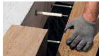
Dann wird die mineralische Wärmedämmung einfach über den Anker gedrückt – ohne Anstechen, ohne Spezialwerkzeug.
