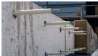
Der Verbundmörtel ist in der Regel nach 30 bis 60 Minuten vollständig ausgehärtet.
