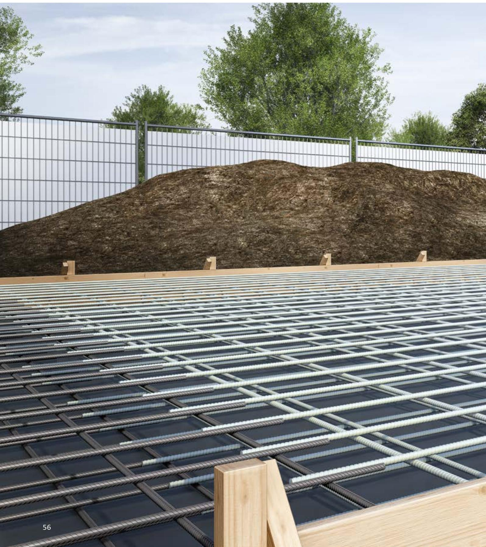
*In korrosiven Umgebungen und unter elektromagnetischem Einfluss stößt Stahlbewehrung an ihre Grenzen. Im Kern spezieller Funktionsbauten kommt deshalb Schöck Combar® zum Einsatz. Diese Glasfaserbewehrung hat ähnliche Materialeigenschaften wie Betonstahl, rostet aber nicht, ist nicht magnetisierbar und leitet weder elektrische noch thermische Ströme. Damit haben Ingenieure und Verarbeiter hochfeste und dauerhafte Bauprodukte an der Hand, die gänzlich neue Möglichkeiten bieten.*
