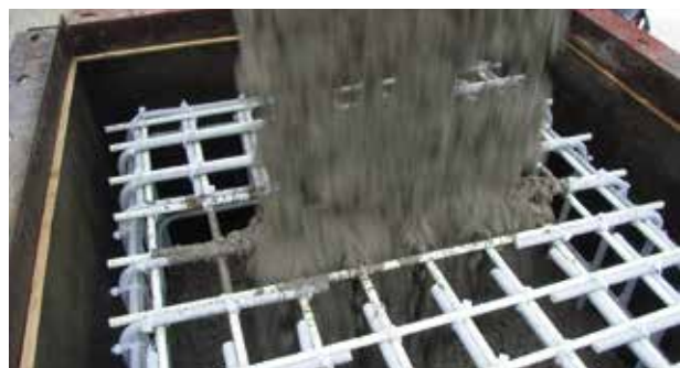
Die Schöck Combar® Glasfaserbewehrung wird wie herkömmlicher Betonstahl bestellt und eingebaut.
