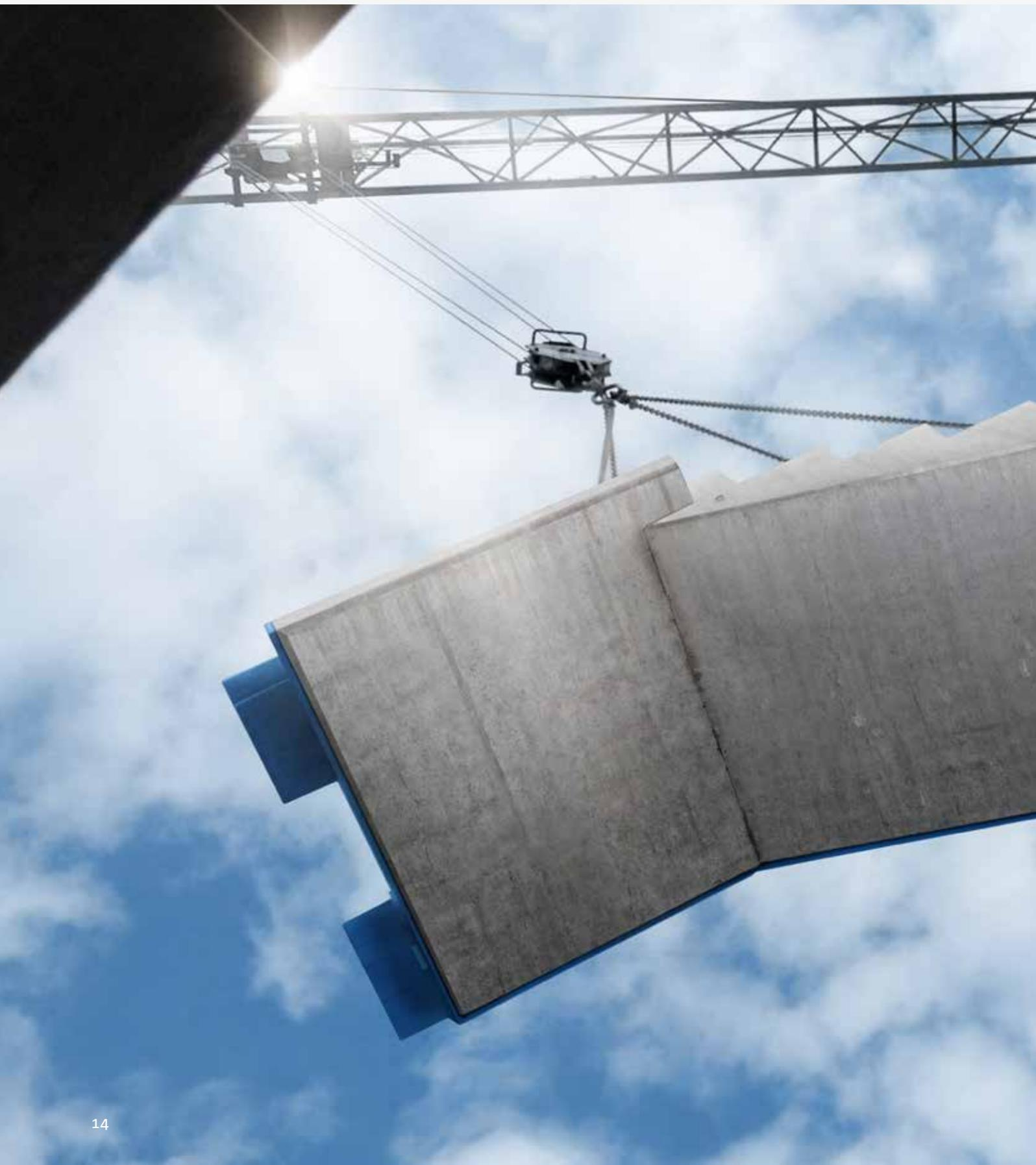
Die Treppe wird mit der Schöck Tronsole® für eine schallbrückenfreie Ausführung umlaufend beklebt. Dadurch ergibt sich ein optimales Schallschutzsystem. Im Vergleich zu aufwendigen Einzellösungen auf der Baustelle werden mit der Schöck Tronsole® Einbaufehler minimiert und das Verletzungsrisiko verringert. Zusätzlich reduziert die blaue Linie die Gefahr von Schallbrücken.
