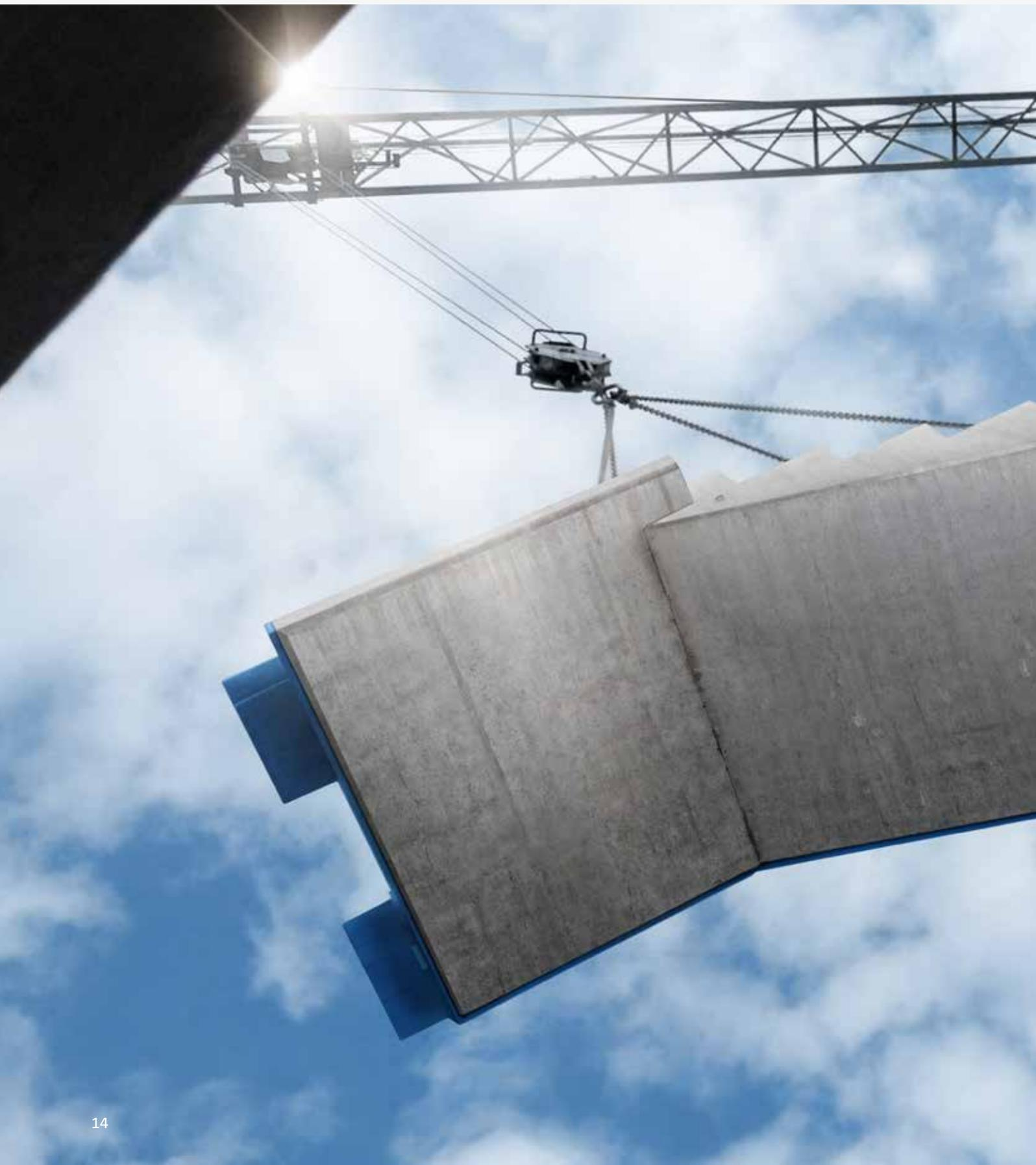
Die Treppe wird mit der Schöck Tronsole® für eine schallbrückenfreie Ausführung umlaufend beklebt. Dadurch ergibt sich ein optimales Schallschutzsystem – die blaue Linie. Im Vergleich zu aufwendigen Einzellösungen auf der Baustelle werden mit der Schöck Tronsole® Einbaufehler minimiert und das Verletzungsrisiko verringert. Zusätzlich reduziert die blaue Linie die Gefahr von Schallbrücken.
