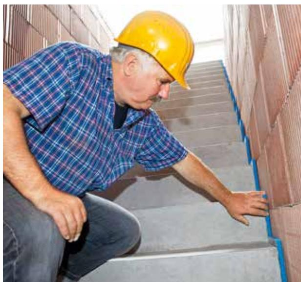
Die Schöck Tronsole® Typen bilden im System eine blaue Linie. Diese kennzeichnet bei der Bauabnahme den schallbrückenfreien Anschluss.
