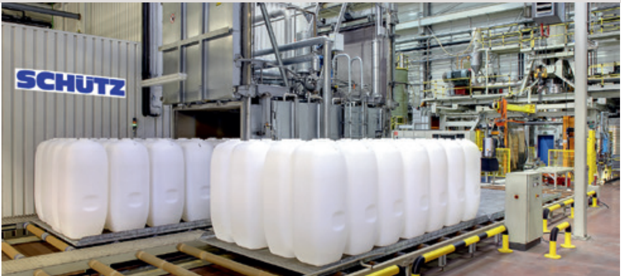
SCHÜTZ SMP Anlage
