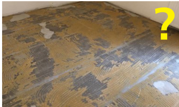
FlieBenkleber abschleifen oder nivellieren (bauseits), dann fräsbar
