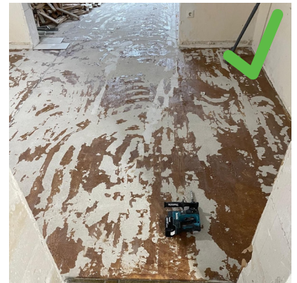
Risse verharzen (bauseits), dann fräsbar
