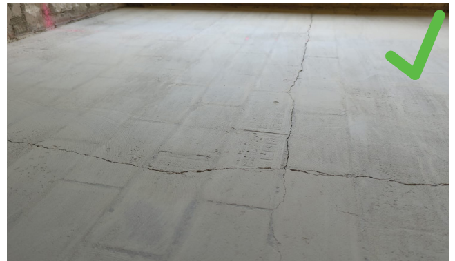
Risse verharzen (bauseits), dann fräsbar
