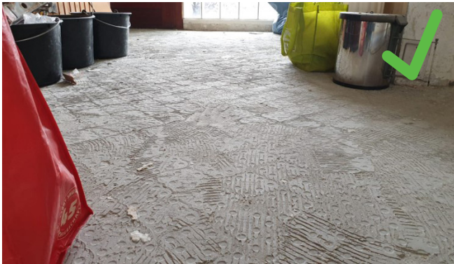
FlieBenkleber abschleifen oder nivellieren (bauseits), dann fräsbar
