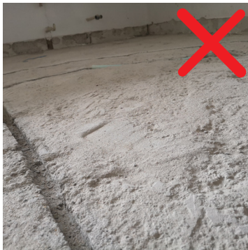
FlieBenkleber abschleifen oder nivellieren (bauseits), dann fräsbar
