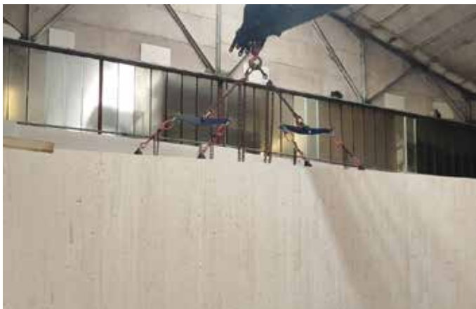
Pocket Traverse beim Verheben in einer Halle.
