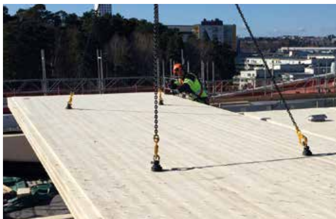
Pick beim Verheben von CLT
