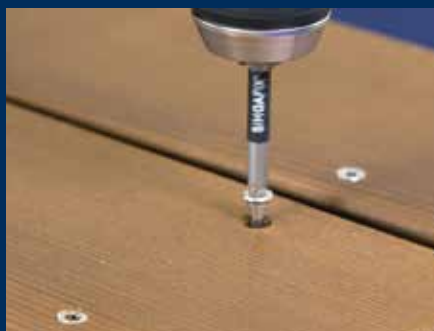
3. Neue Schraube einschrauben
