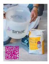
Streuen Sie dann das Spachtelpulver gleichmäßig solange in das Wasser ein, bis die Oberfläche leicht damit bedeckt ist. Achten Sie auf das Mischverhältnis, welches Sie auf der Rückseite der Verpackung finden! Lassen Sie das Spachtelpulver anschließend ca. 2 Minuten einsumpfen.
