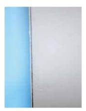
**TIPP:** Legen Sie nach dem groben Verspachteln des Kantenprofils einen Glasfasersteifen auf, bevor Sie noch mal darüber spachteln. So vermeiden Sie, dass man die Profillöcher später sieht. Die Oberfläche ist somit homogener und das Einfallverhalten wird vermieden.
