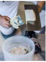
ACHTUNG: Sobald die Masse anfängt fest zu werden, darf kein Wasser mehr hinzugefügt werden, da sonst die Gefahr von Fugenrissen besteht.
