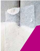
TIPP: Wir empfehlen Ihnen bei Holzunterkonstruktionen immer einen Bewehrungsstreifen einzusetzen.
