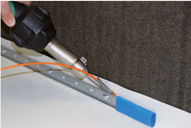
Randfixierung mit FLAGON Befestigungsschiene
