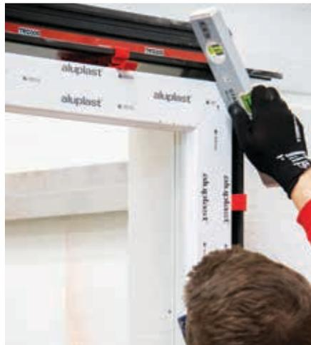
**13** Fenster vorbohren, einsetzen und ausrichten
