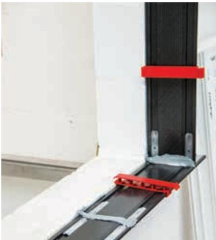
**12** Ecken abdichten und Federclipse positionieren
