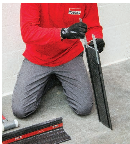
04 Kurze Elemente/Reste können mit dem Längsverbinder verbunden werden
