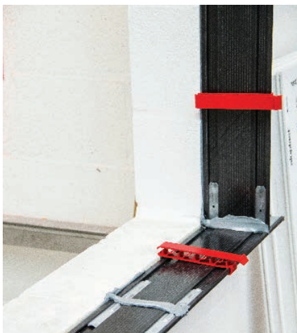
12 Ecken abdichten und Federclipsse positionieren
