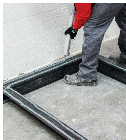
08 Klebstoff umlaufend, in 2 Reihen, auf den Rahmen aufbringen
