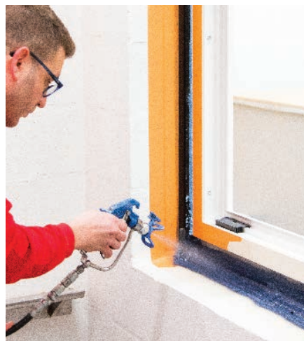
16 Fensterabdichtung Innen Soudatight LQ/SP
