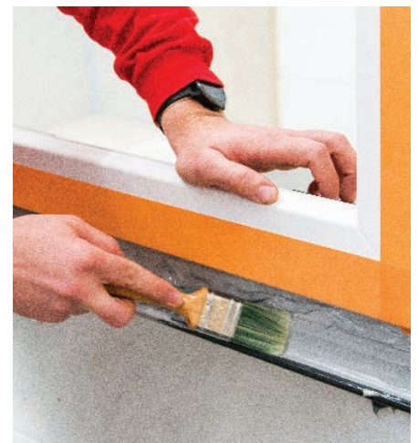
17 Fensterabdichtung Außen Soudatight Hybrid
