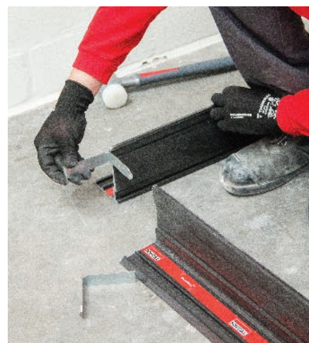
03 Eckverbinder befestigen
