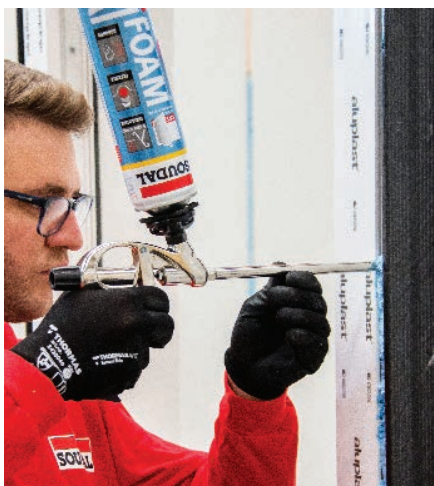
15 Federclipsse entfernen und Fenster abdichten
