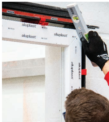
13 Fenster vorbohren, einsetzen und ausrichten
