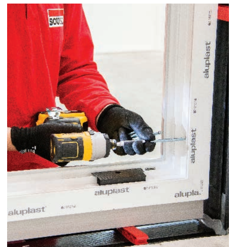
14 Fenster mechanisch befestigen
