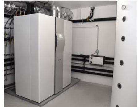
Heizung und Warmwasserbereitung sowie auf Wunsch auch Kühlung des Gebäudes über die Heizflächen.
