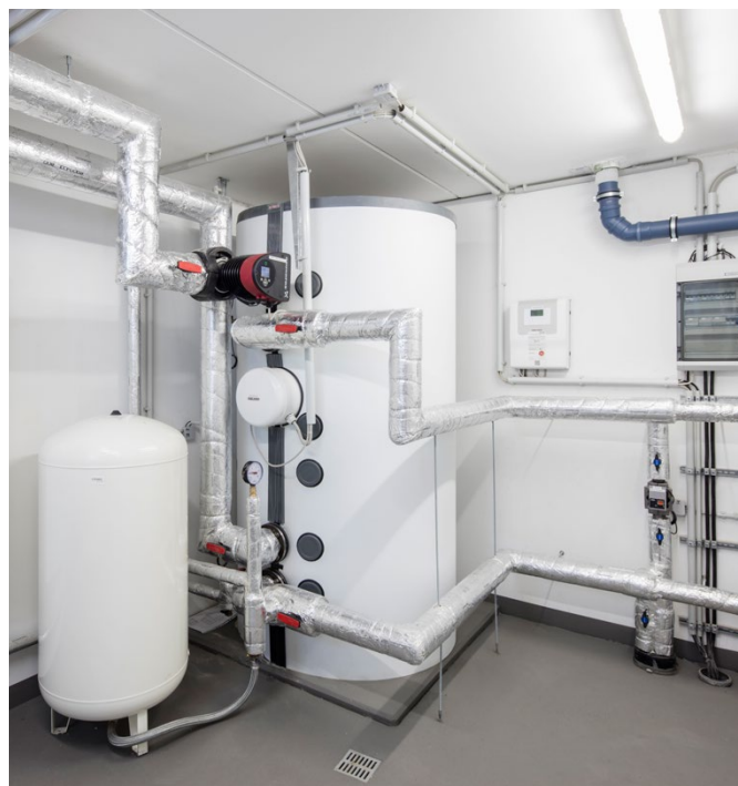
Im Technikraum wird die Wärme in einem 1.500-Liter-Speicher bevorratet.
