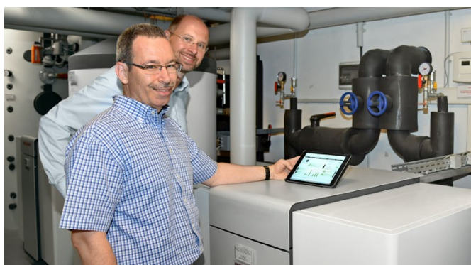
Christian Ehret (vorne) von der Bau- und Wohnungsgenossenschaft von 1892 eG sowie STIEBEL ELTRON-Experte Patrick Faika mit einem iPad, das alle Infos und Daten der hier eingesetzten Erdreich-Wärmepumpe zeigt.
