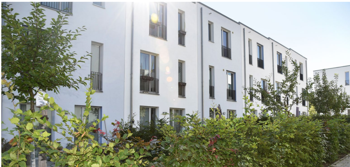
Insgesamt umfasst der zweite Bauabschnitt der „Neuen Gartenstadt Falkenberg“ 95 Wohnungen. Mal sind wie hier Reihenhäuser errichtet worden, mal sind es Geschosswohnungsbauten.
