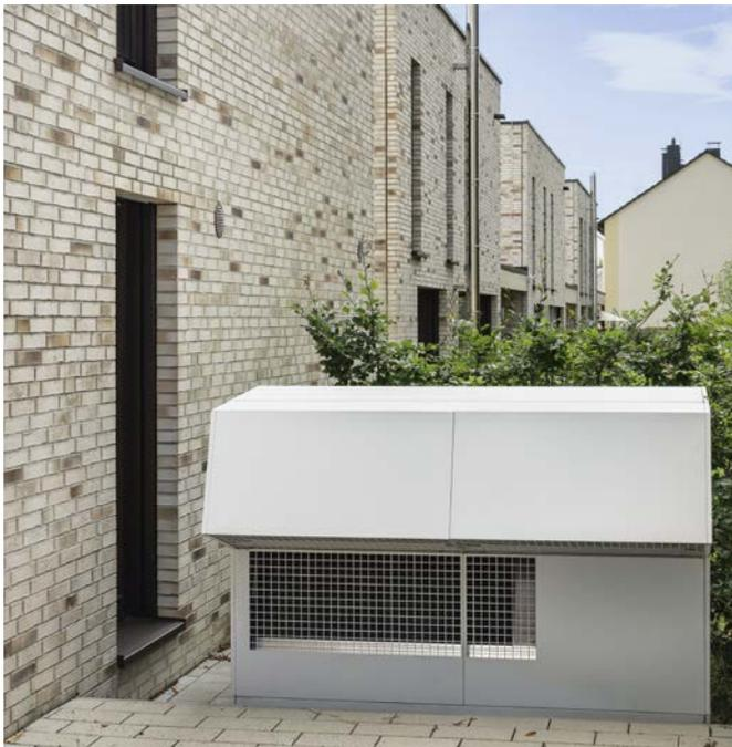
**Pro Mehrfamilienhaus ist außen eine Luft-Wasser-Wärmepumpe WPL 57 von STIEBEL ELTRON aufgestellt, der Rest der Anlage befindet sich in einem Technikraum. Die Anlage arbeitet mit 35 °C Vorlauftemperatur und etwa 28 °C Rücklauftemperatur.**
