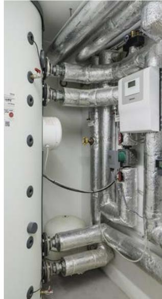
**Jedes Mehrfamilienhaus verfügt auch über einen Pufferspeicher SBP 1000 E, der die Wärme bevorratet. Über den Wärmepumpenmanager werden alle eingestellten Funktionen automatisch geregelt.**
