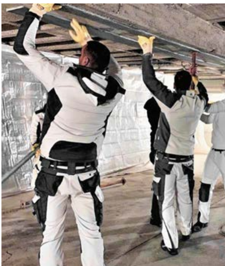
Tiefgarage Eintrachtstraße, München, DE StoCretec-Kompetenzen: StoConcrete Carbon Plate, oberflächig geklebt, StoPox Mörtel standfest
