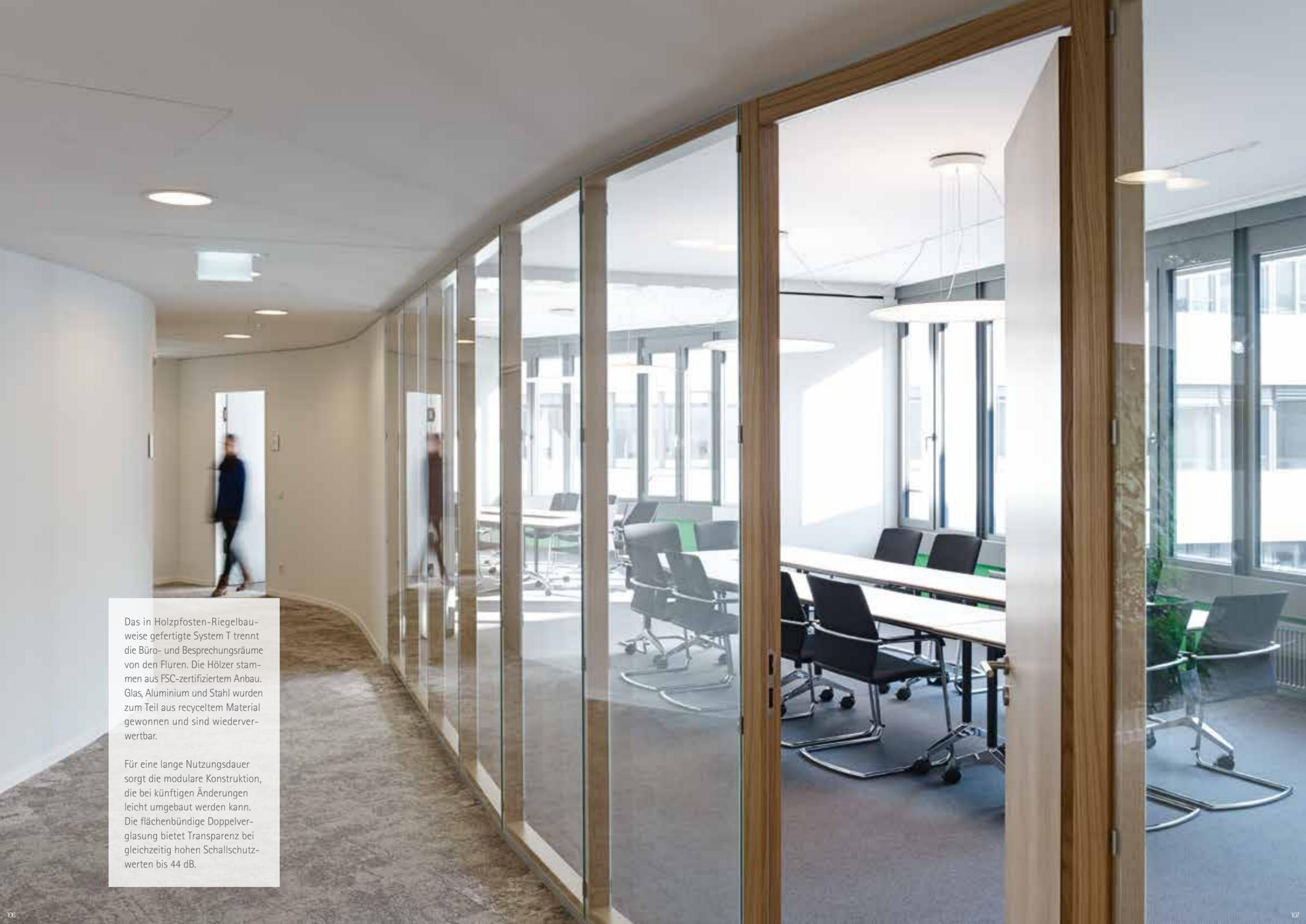
Das in Holzpfosten-Riegelbauweise gefertigte System T trennt die Büro- und Besprechungsräume von den Fluren. Die Hölzer stammen aus FSC-zertifiziertem Anbau. Glas, Aluminium und Stahl wurden zum Teil aus recyceltem Material gewonnen und sind wiederverwertbar.
