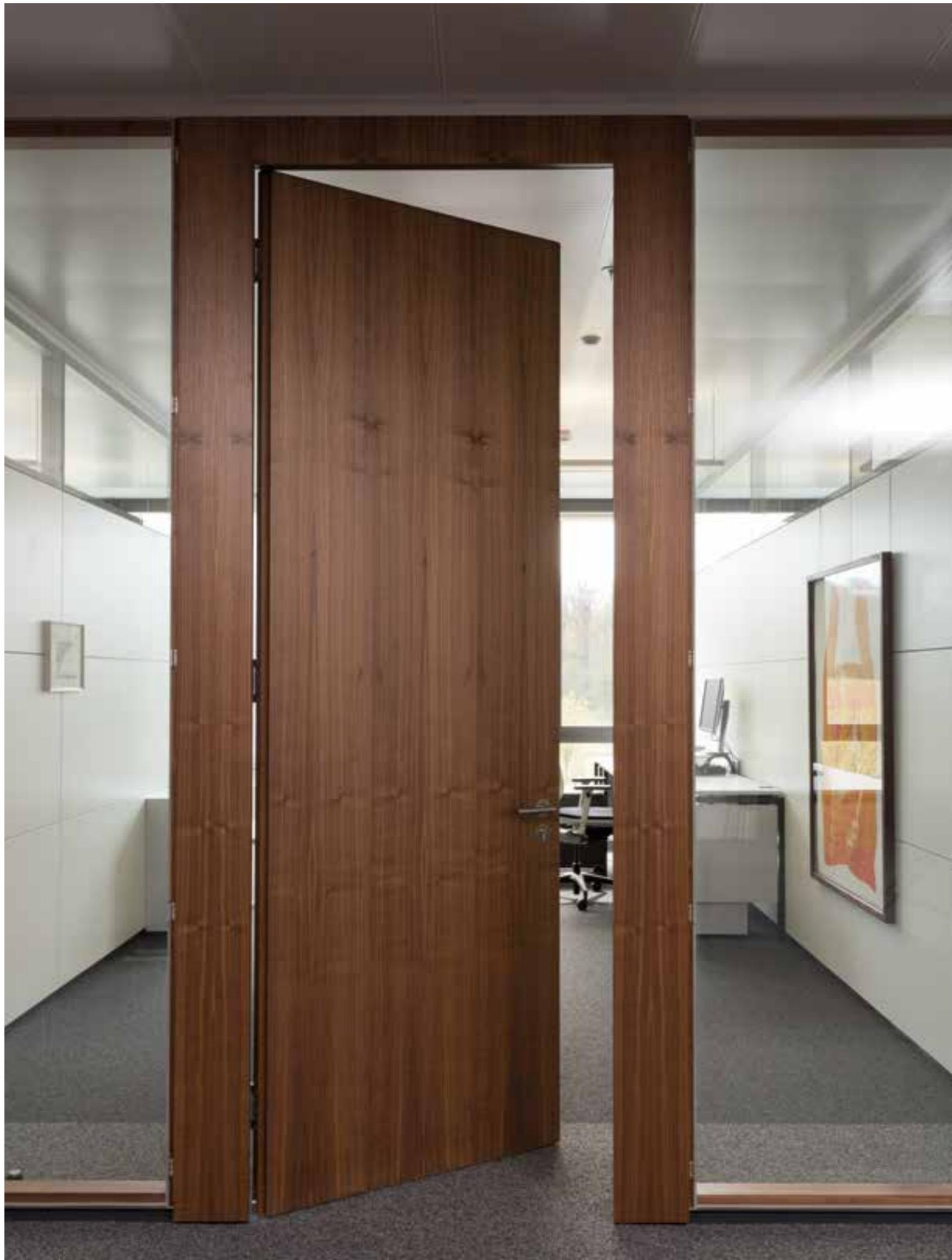
OLYMP entschied sich bewusst für die flexiblen Trennwandsysteme von Strähle, um auf veränderte Anforderungen jederzeit mit räumlichen Anpassungen reagieren zu können. Die Bürozwischenwände wurden als Oberlichtwände mit den Systemen 2000 und 2300 umgesetzt. Je nach Nutzung kamen raumhohe Volltüren bzw. zweiflügelige Türen zum Einsatz. Dank der Kompatibilität der unterschiedlichen Systeme ist eine durchgängig einheitliche Optik gewährleistet.
