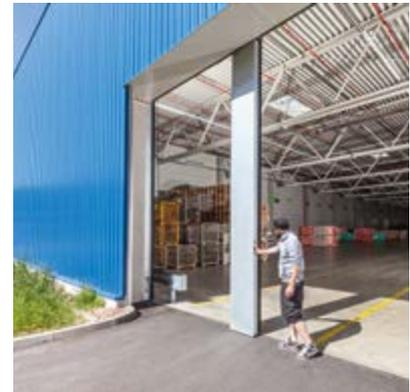
Durch das spezielle Laufschiensystem lässt sich der entriegelte Mittelpfosten einfach manuell an den Rand schieben. Beide Tore werden geöffnet und die Ausfahrt kann ohne großes Rangieren passiert werden.
