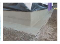
**Ohne Geruch:** Das lösemittelfreie System ermöglicht eine geruchsarme Verarbeitung in innenliegenden Technikräumen. **Mit Soforteffekt:** Triflex SmartTec kann auf Beton ohne Grundierung angewendet werden und ist sofort funktionssicher.
