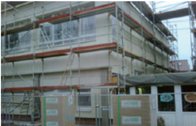
Objekt: Berlinschule Bad Nenndorf / Niedersachsen (Massivbauweise mit vorgeständerter Fassade UdiSPEED® 40 mm)
