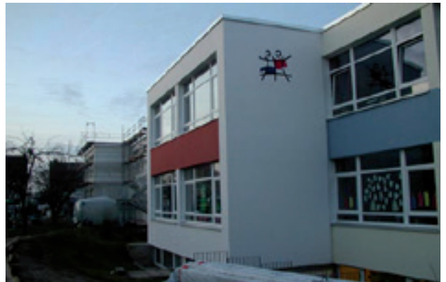
Objekt: Berlinschule Bad Nenndorf / Niedersachsen (Massivbauweise mit vorgeständerter Fassade UdiSPEED® 40 mm)
