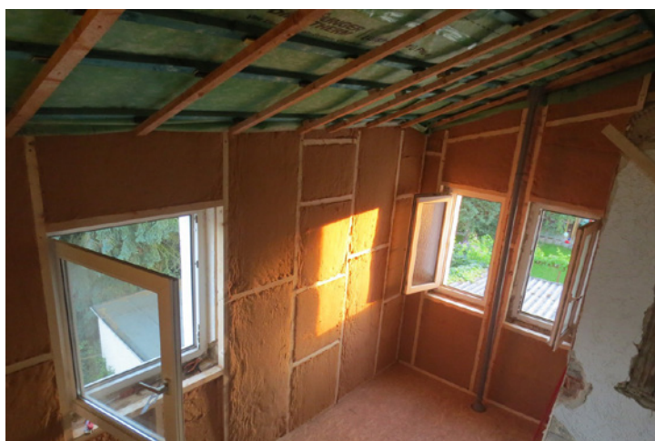
Ständerwand von innen gedämmt
