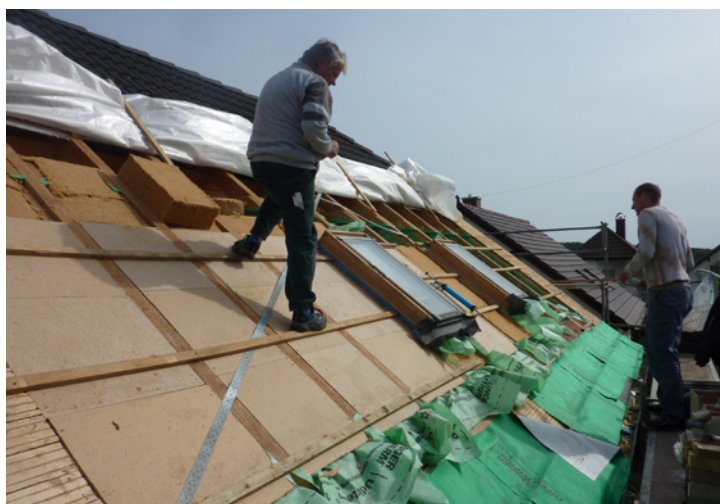
SANIERUNG UdiTOP® und UdiSTEAM® Winddichtheit
