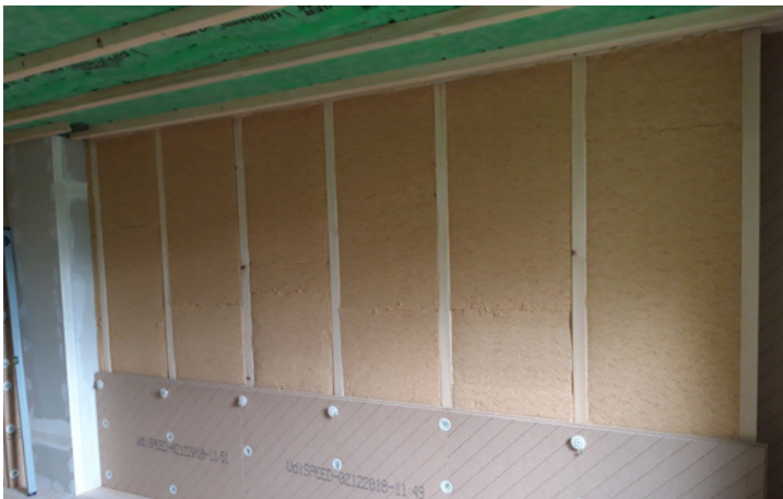
Ständerwand gedämmt mit UdiFLEX® und zweiseitig mit UdiSPEED® beplankt. Putzbeschichtung kann erfolgen
