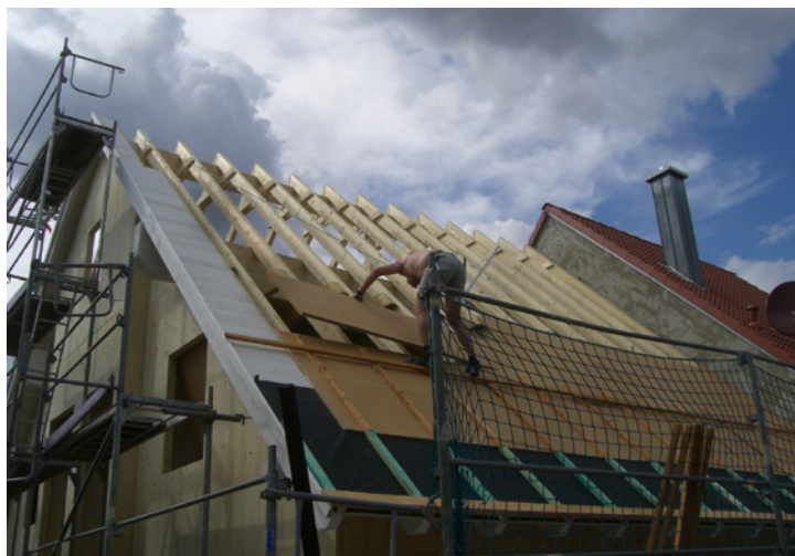
NEUBAU UdiTOP® 22 mm Plattenmontage
