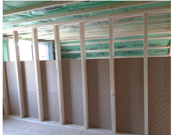
Ständerwand für Raumteiler gestellt und einseitig mit UdiSPEED® beplankt
