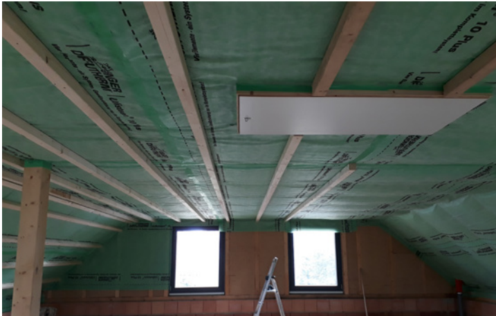
Dachboden vollflächig gedämmt, Raumteilung vorbereitet
