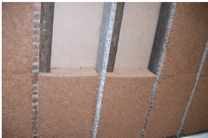
Zwischensparrendämmung
