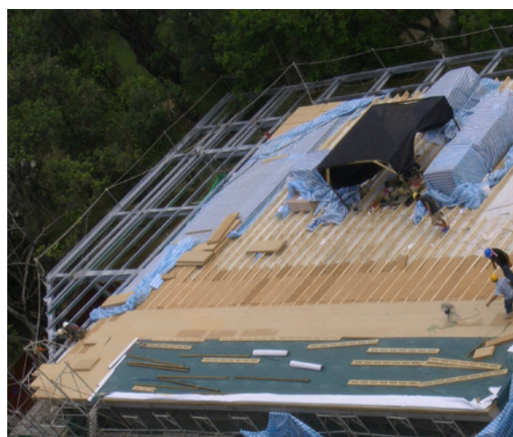
Aufdachdämmung
