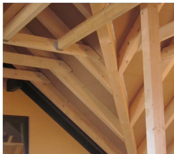
UdiTOP® Anschluss an Bestandsgebäude von innen
