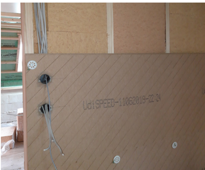
Kabelführung kann problemlos in das Gefach zwischen UdiFLEX® und UdiSPEED® gelegt werden
