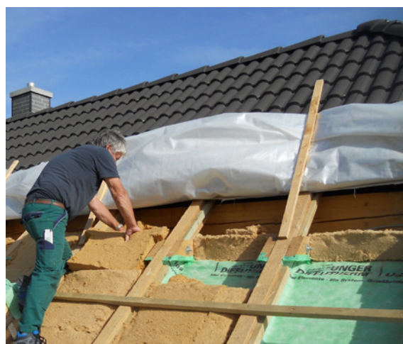
Dachsanierung von außen
