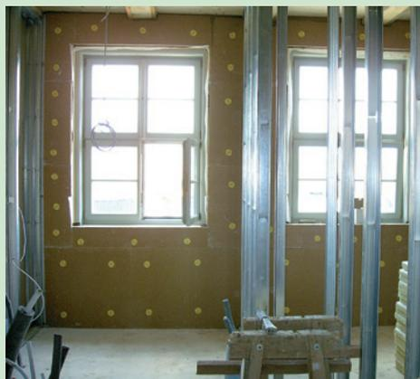
bereits montierte **UdiIN®** Holzfaserdämmplatten
