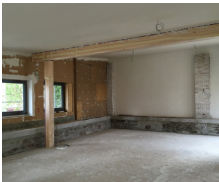
UdiSUN® im Deckenbereich verspachtelt
