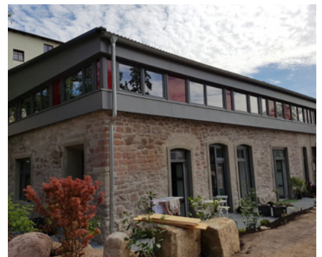
Außenansicht nach Fertigstellung
