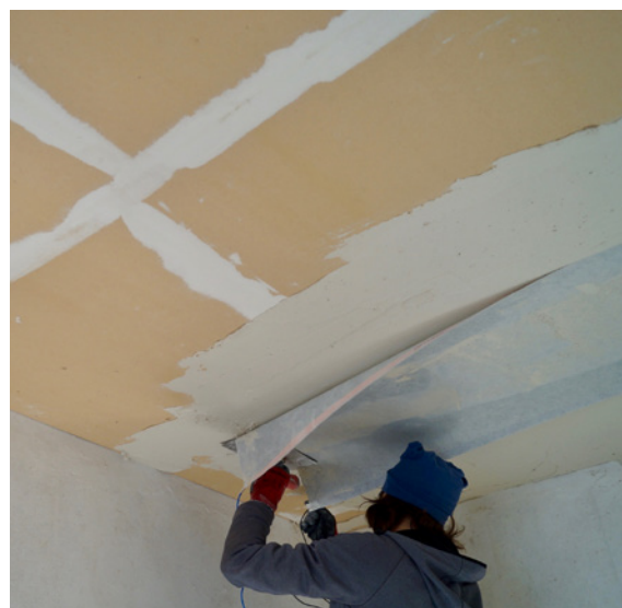
UdiSUN® beim Einspachteln
