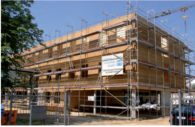
Objekt: Leipzig-Neukirchitzsch / Sachsen (Holzständerneubau mit UdiFRONT® 60 mm)
