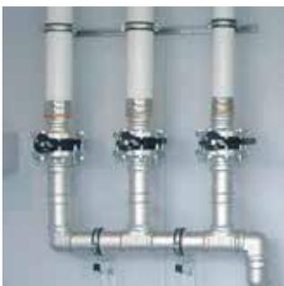
*Flexibler Aufbau von Hauptverteilern – mit dem modularen Fittingsystem und den dazugehörigen Distanzadaptern lassen sich Verteiler unterschiedlicher Größe flexibel und mit wenigen Handgriffen anfertigen.*
