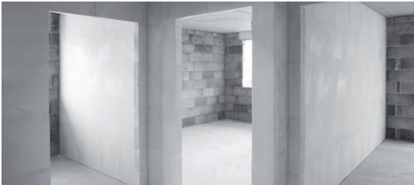
Rohbaubegleitender Einbau von Gips-Wandbauplatten
