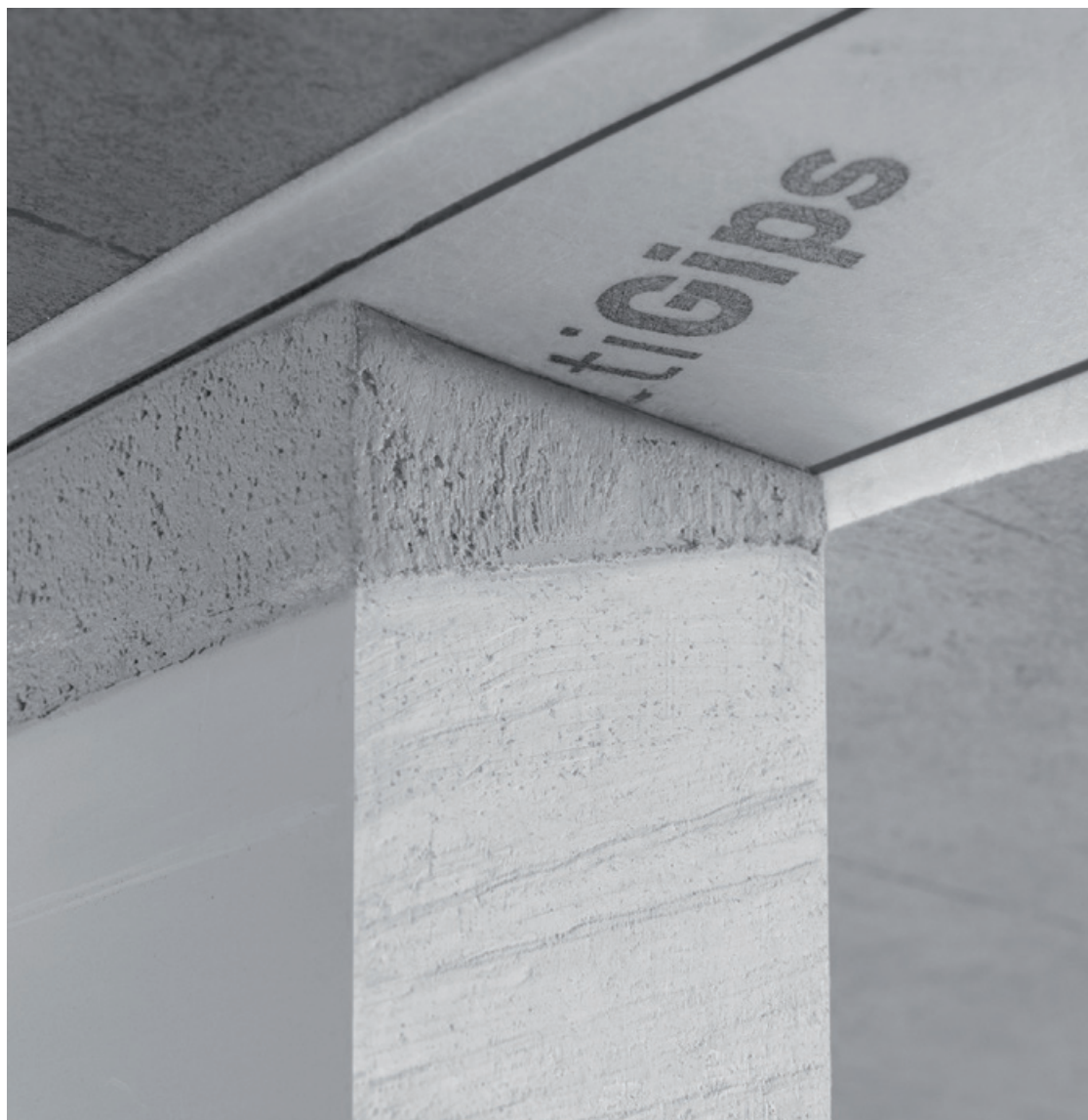
Elastischer Anschluss mit MultiGips AkustikPro 120-3
