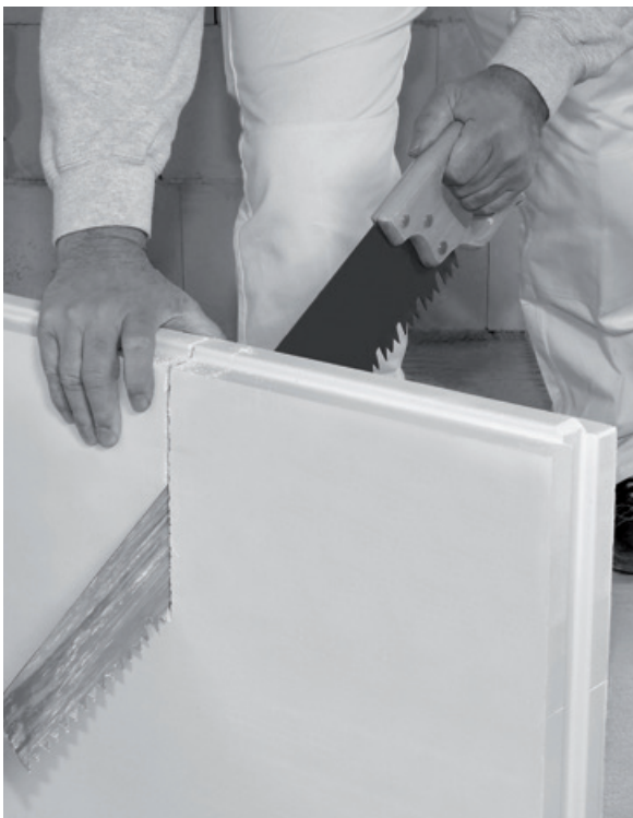
Rohbaubegleitender Einbau von Gips-Wandbauplatten
