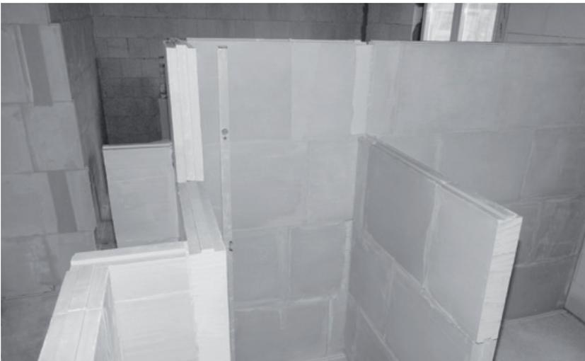
Typisch für den Wohnungsbau sind 80 oder 100 mm dicke Wände. In Lichtenrade wurde mit 100 mm dicken Platten gearbeitet, deren flächenbezogene Masse ca. 87 kg/m<sup>2</sup> beträgt. Selbst bei drei Meter hohen Wänden liegt die Linienlast der Wände damit bei nur 2,61 kN/m, was jede mit dem erforderlichen Trennwandzuschlag bemessene Decke problemlos trägt.
