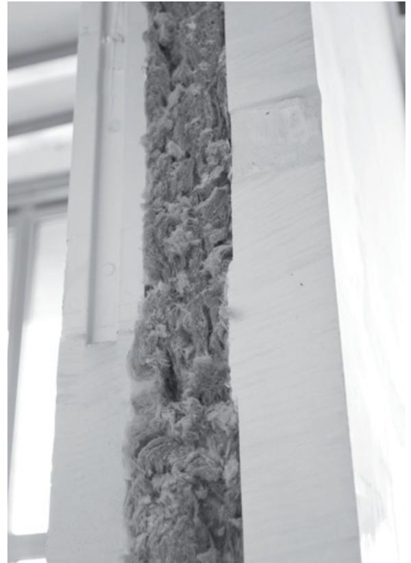
zweischalige Konstruktionen mit innenliegender Mineralwolle-Dämmung ausgeführt.
