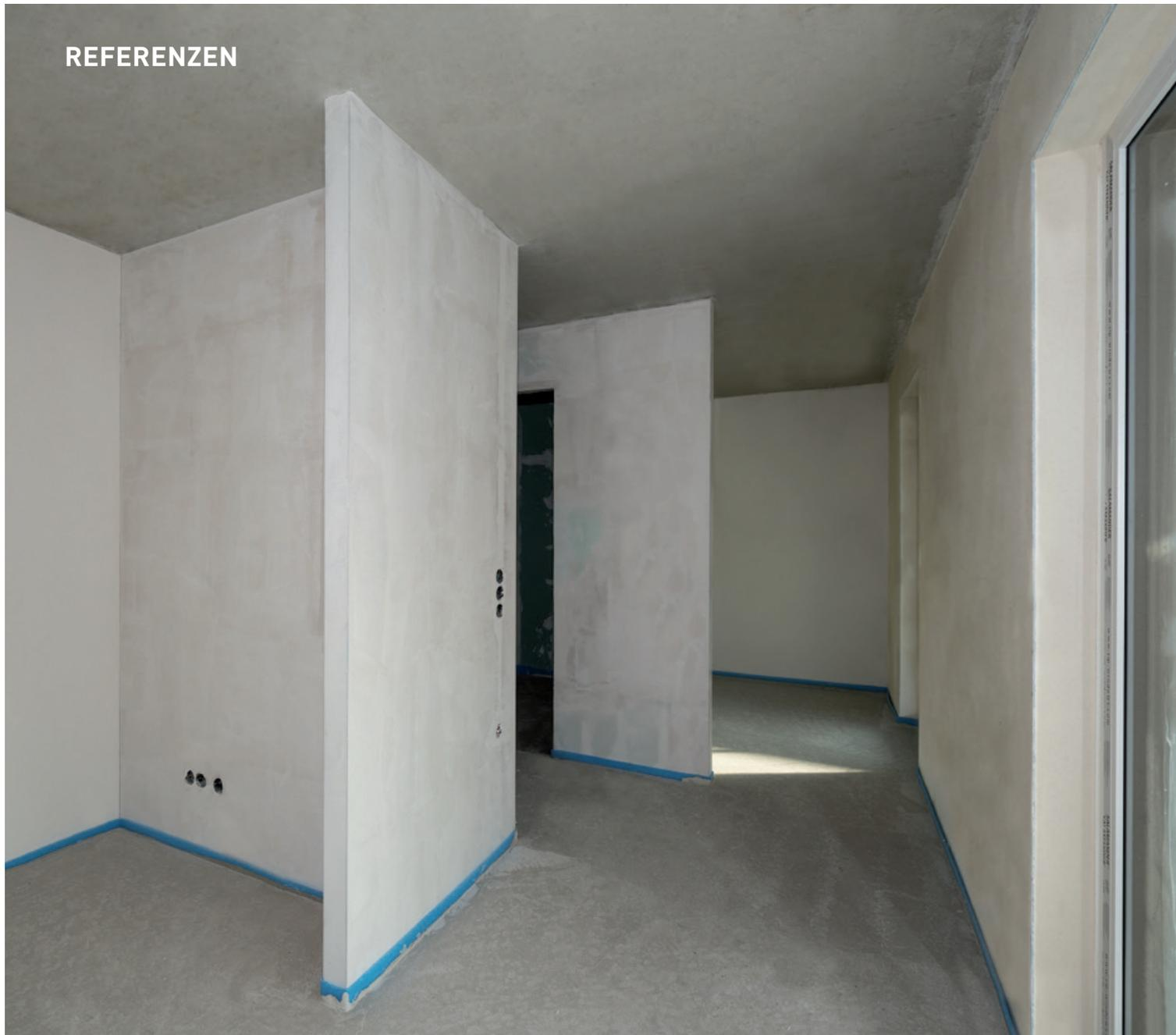
Mit Mikroapartments entsteht in Deutschland immer öfter bezahlbarer Wohnraum. Die enorme Resonanz beruht auf konfektionierten Raum- und Möblierungskonzepten, hinter denen häufig Innenwände aus massiven Gips-Wandbauplatten stehen.
