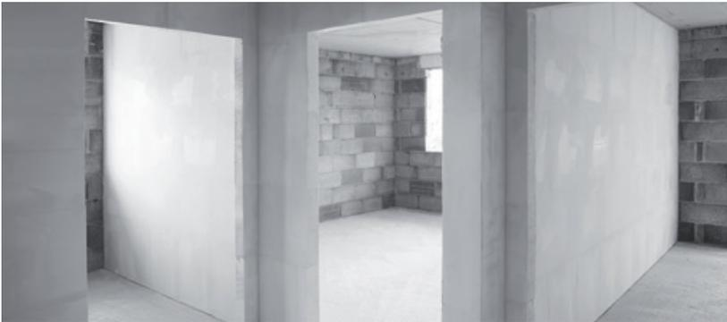
Rohbaubegleitender Einbau von Gips-Wandbauplatten
