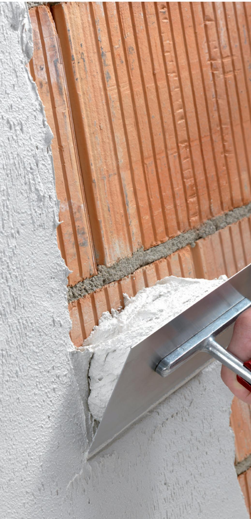
Aufgrund ihres schnelleren Versteifungsbeginns und der daran angepassten Verarbeitungszeiten werden MultiGips Handputze – anders als die großflächig aufzutragenden Gipsmaschinenputze – vor allem für das einlagige Verputzen kleinerer Flächen eingesetzt. Die Trockenmörtel werden als Sackware verarbeitungsfertig zur Baustelle geliefert. Eigenschaften und Verarbeitbarkeit der Mörtel sind werkseitig so eingestellt, dass sie auf allen geeigneten bauüblichen Putzgründen angewendet werden können.
