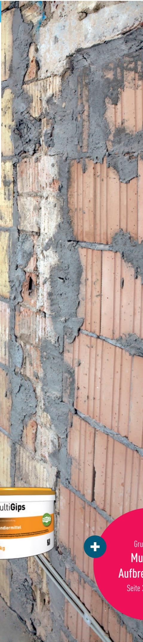
Bei unterschiedlichen Putzgründen muss mit Spannungen im Putzgrund infolge der abweichenden thermischen Längenänderung gerechnet werden. Bei Mischmauerwerk sollte deshalb stets eine Putzbewehrung im zugbelasteten Bereich der Putzlage, d.h., im oberen raumseitigen Drittel vorgesehen werden. Bestehen Bedenken bezüglich der Tragfähigkeit des Putzgrundes, muss ein Putzträger verwendet werden, damit der Putz unabhängig vom Putzgrund hergestellt werden kann.
