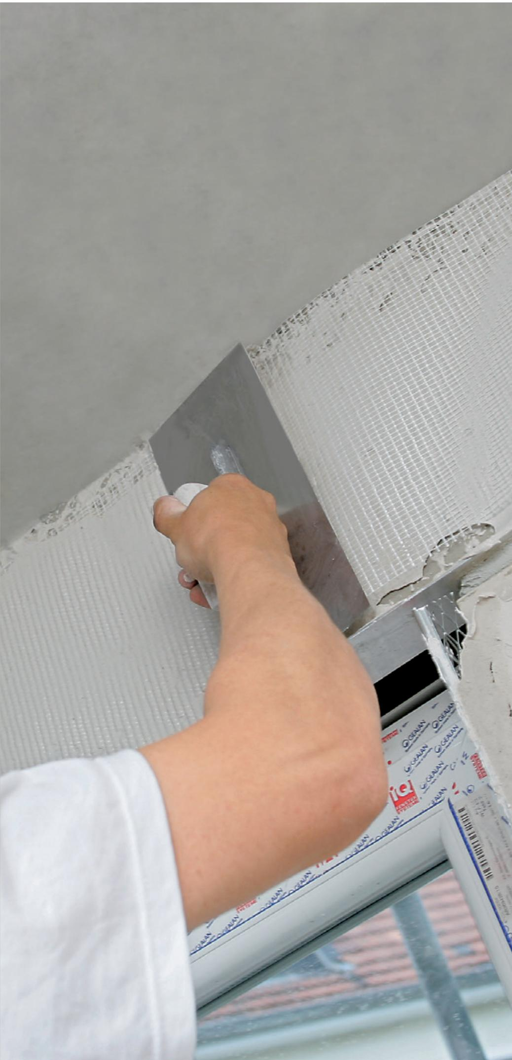
Wird eine Erhöhung des Risswiderstandes des Putzes durch eine Putzbewehrung für erforderlich gehalten, so sollte diese zur Erfüllung ihrer Aufgabe im oberen raumseitigen Drittel der Putzlage – nach DIN 18550-2 die zugbelastete Zone des Putzes – eingebaut werden; direkt auf dem Putzgrund fixierte Gewebe sind funktionslos.
