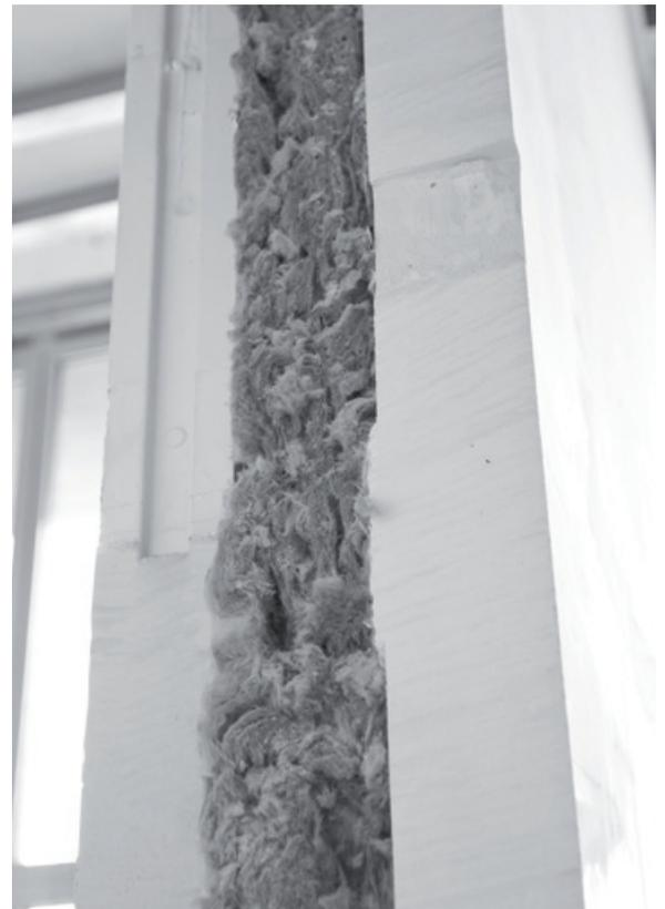
zweischalige Konstruktionen mit innenliegender Mineralwolle-Dämmung ausgeführt.
