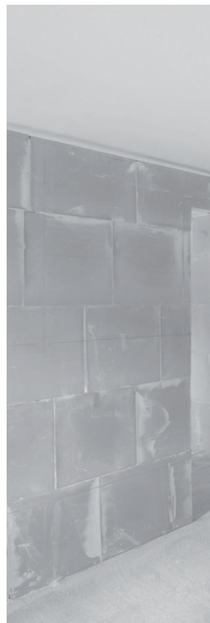
INNENWÄNDE AUS GIPS-WANDBAUPLATTEN WERDEN PARALLEL ZUM ROHBAU ERRICHTET – IN DER REGEL BEREITS **NACH DEM EINBAU DER ERSTEN GESCHOSSDECKEN**. DIESES BESCHLEUNIGTE BAUEN IST EINES DER ZENTRALEN VORTEILSKRITERIEN FÜR PROFESSIONELLE ANWENDER.
