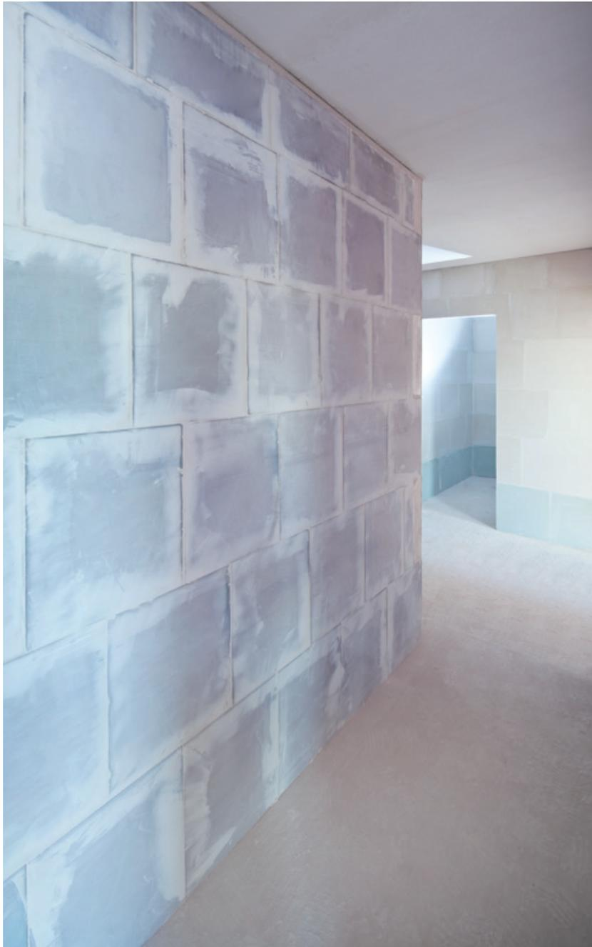
aus MultiGips D100-Rmax Schallschutzplatten (rötlich eingefärbt) konnte dieses Ziel erreicht werden: Ihr Schalldämm-Maß  $R_w$  beträgt 46 dB bei einer Rohdichte von ca.  $1.200 \text{ kg/m}^3$  und bei einer Wanddicke von gerade einmal 100 mm. Die Besonderheit der Bauweise ist der elastische Anschluss der Innenwände an alle angrenzenden
