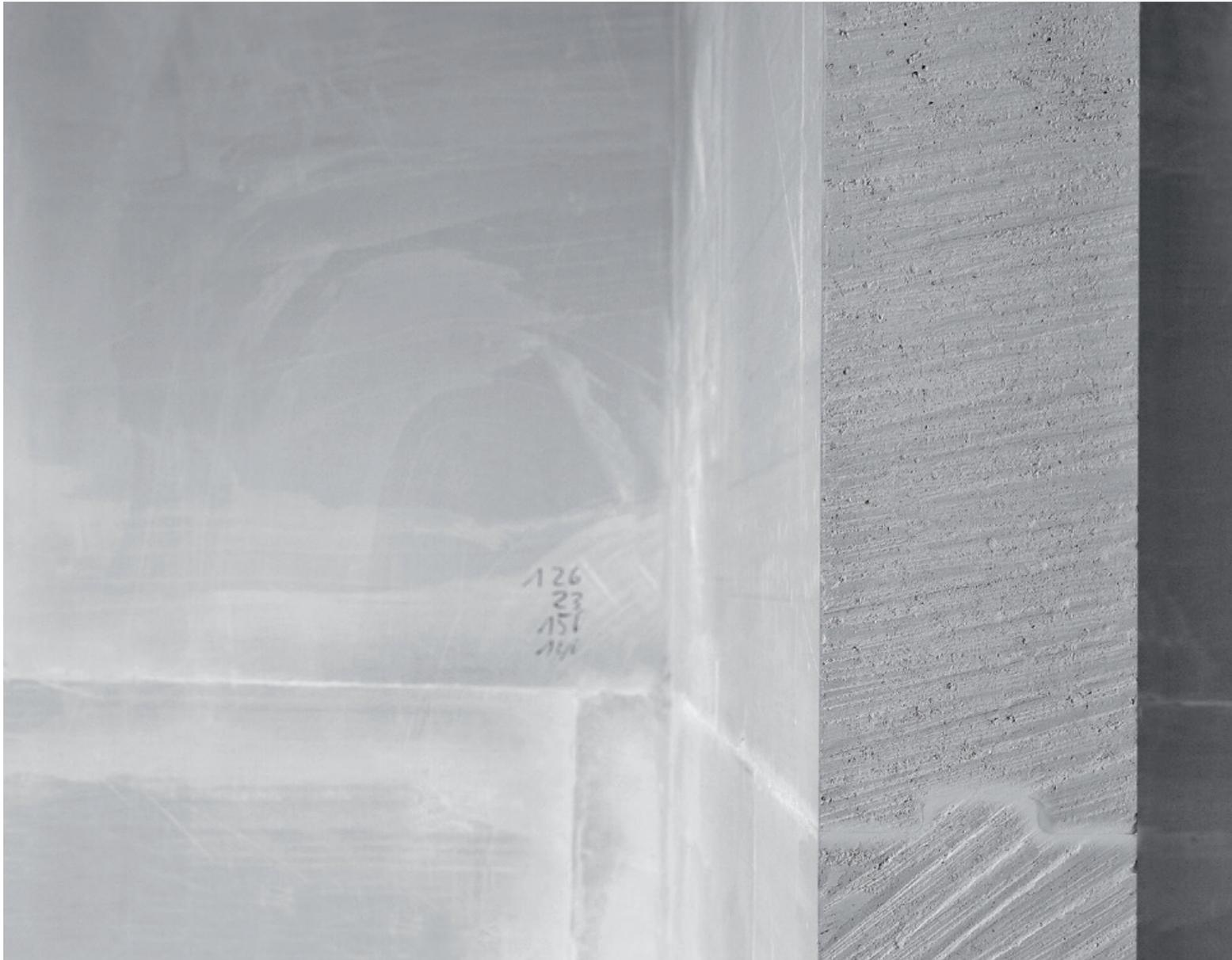
Massive Gips-Wandbauplatten werden aus dem Mineral Gips hergestellt. Baubiologisch einwandfrei eignen sie sich in hervorragender Weise für wohngesunde Baukonzepte. Sie sind diffusionsoffen und bieten beste Voraussetzungen für ein behagliches Innenraumklima.
