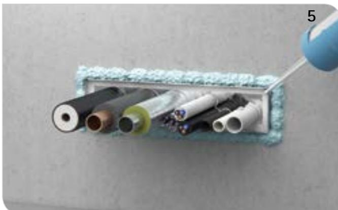
Fugen des Gehäuses sowie die Restöffnungen der Schaumplatten mit dauer-elastischem Dichtstoff oder Soudafoam Gun B1 verschließen.
