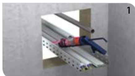
Tangit FP 450 Brandschutz-Paste in Bauteilstärke um und zwischen die Kabel flächig auftragen.
