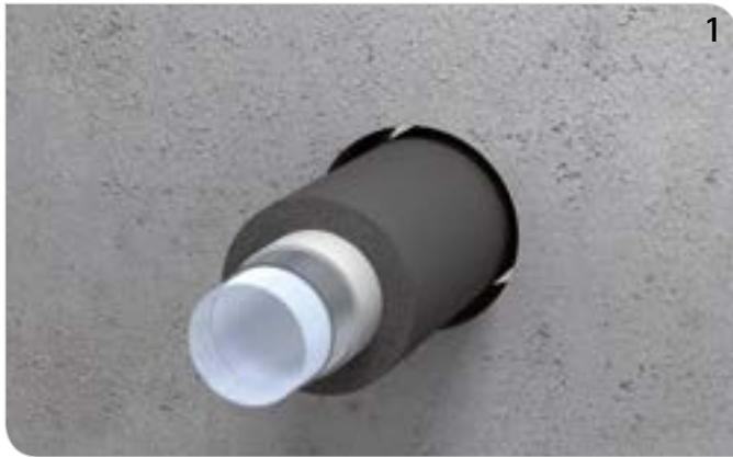
Rohrleitung (ggf. mit Synthekautschukdämmung) installieren.
