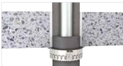
Stahl- und Edelstahlrohre mit außenliegender Manschette (Decke)
