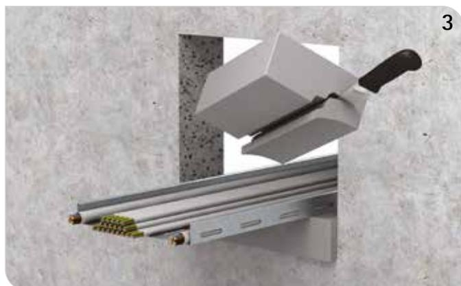
Pacifyre® IWS Brandschutzsteine so ausschneiden, dass sie möglichst eng an der Kabelpritsche bzw. an den Kabeln anliegen.
