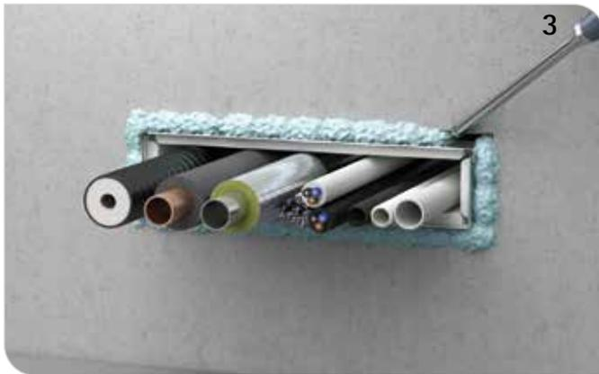
Restspalt rauchgasdicht (mit z. B. Pacifyre® FPM Brandschutzmörtel oder Soudafoam Gun B1) verschließen.
