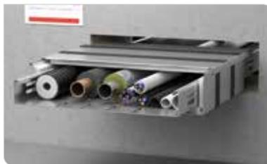
Nachträglicher Einbau durch aufschiebbaren Deckel.
