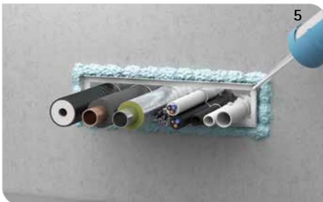
Fugen des Gehäuses sowie die Restöffnungen der Schaumplatten mit dauer-elastischem Dichtstoff oder Soudafoam Gun B1 verschließen.
