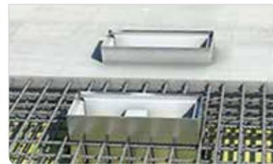
Abschottung von Rohr- und Kabeldurchführungen durch Decken..
