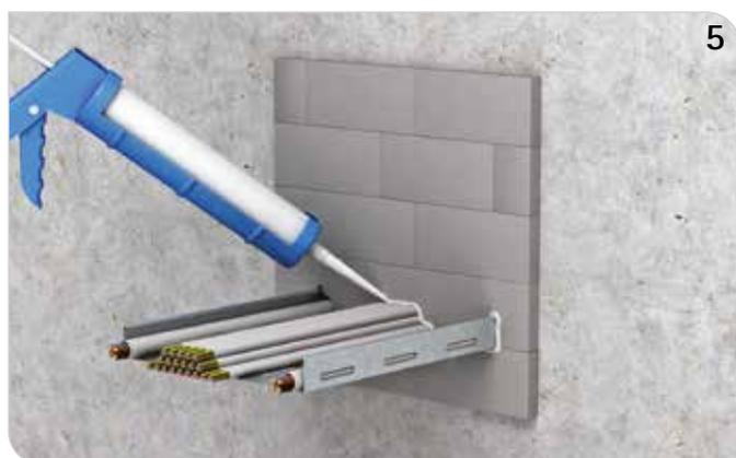
Nach dem Einbringen der Pacifyre® IWS Brandschutzsteine, Restspalte mit Brandschutzschaum verschließen.
