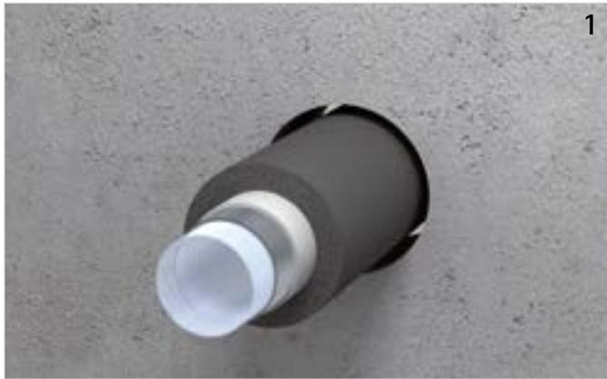
Rohrleitung (ggf. mit Synthekautschukdämmung) installieren.
