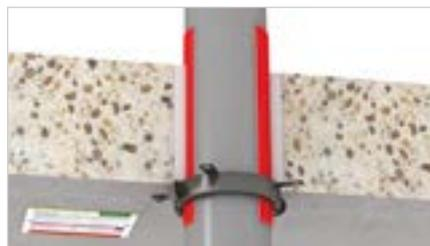
Brennbare Rohre bis Außen-Ø 160 mm
