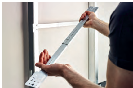
2. Schienenlänge durch Herausziehen an Wand- bzw. Rasterabstand anpassen.
