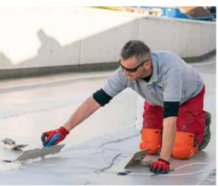
Das Wecryl Abdichtungssystem ist ein nahtloses, mechanisch belastbares, riss- und fugenüberbrückendes Abdichtungssystem. Es enthält eine hochflexible und vliesarmierte Abdichtungsebene sowie abriebfeste Systemschichten für den Personenverkehr. Die flüssige Verarbeitung und der hohe Haftverbund zu fast allen Untergründen ermöglichen zudem die sichere und nahtlose Einbindung von Durchbrüchen und Anschlüssen in die Abdichtung.
