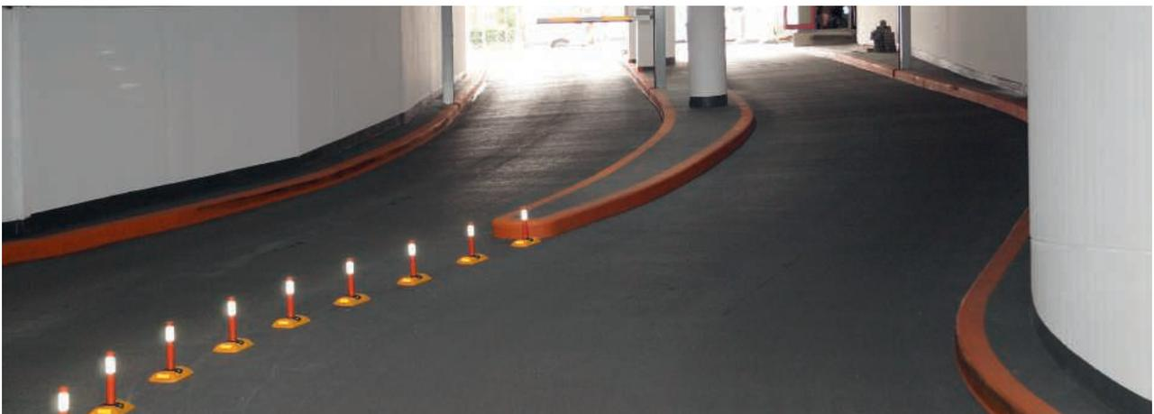
starre Beschichtung für befahrbare, mechanisch stark belastete Flächen
