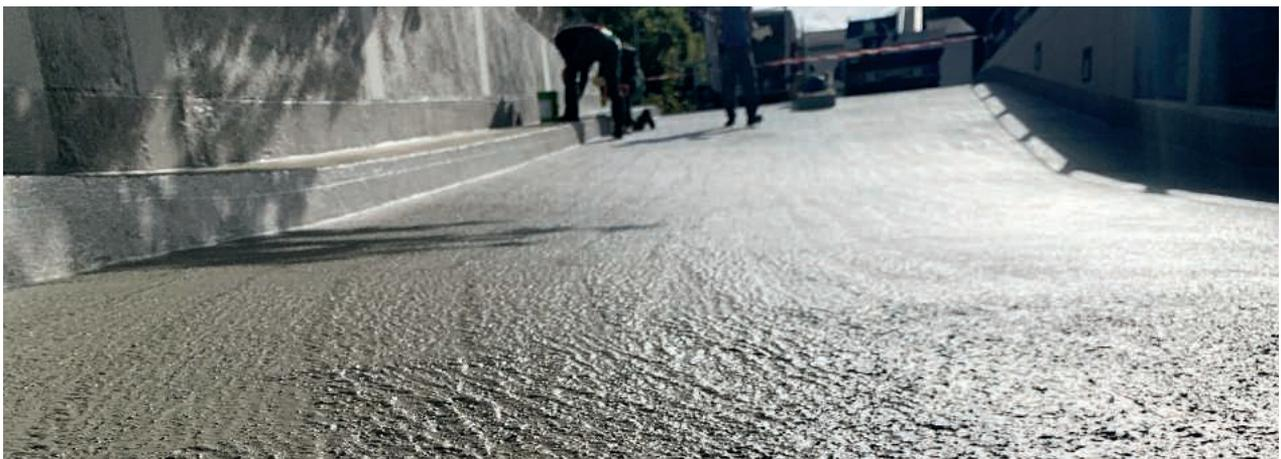
Beschichtung mit erhöhter dynamischer Rissüberbrückungsfähigkeit für begehbare und befahrbare Flächen.
