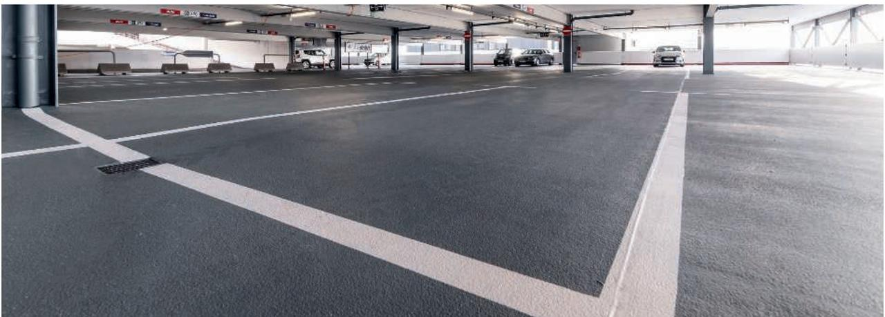
Beschichtung als Dichtungsschicht mit hoher Rissüberbrückung unter Schutz- und Deckschichten für begeh- und befahrbare Flächen
