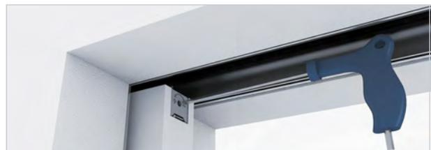
Im Anschluss den vorderen Beschlag am Laufwagen befestigen und in die Türaufnahme einführen. Stirnseitig mit dem Inbusschlüssel die Türeinrichtung feinjustieren.
