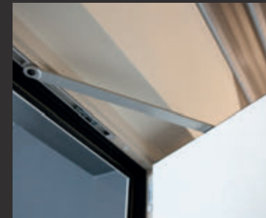
Im Türflügel verdeckter Obertürschließer mit Riegel
