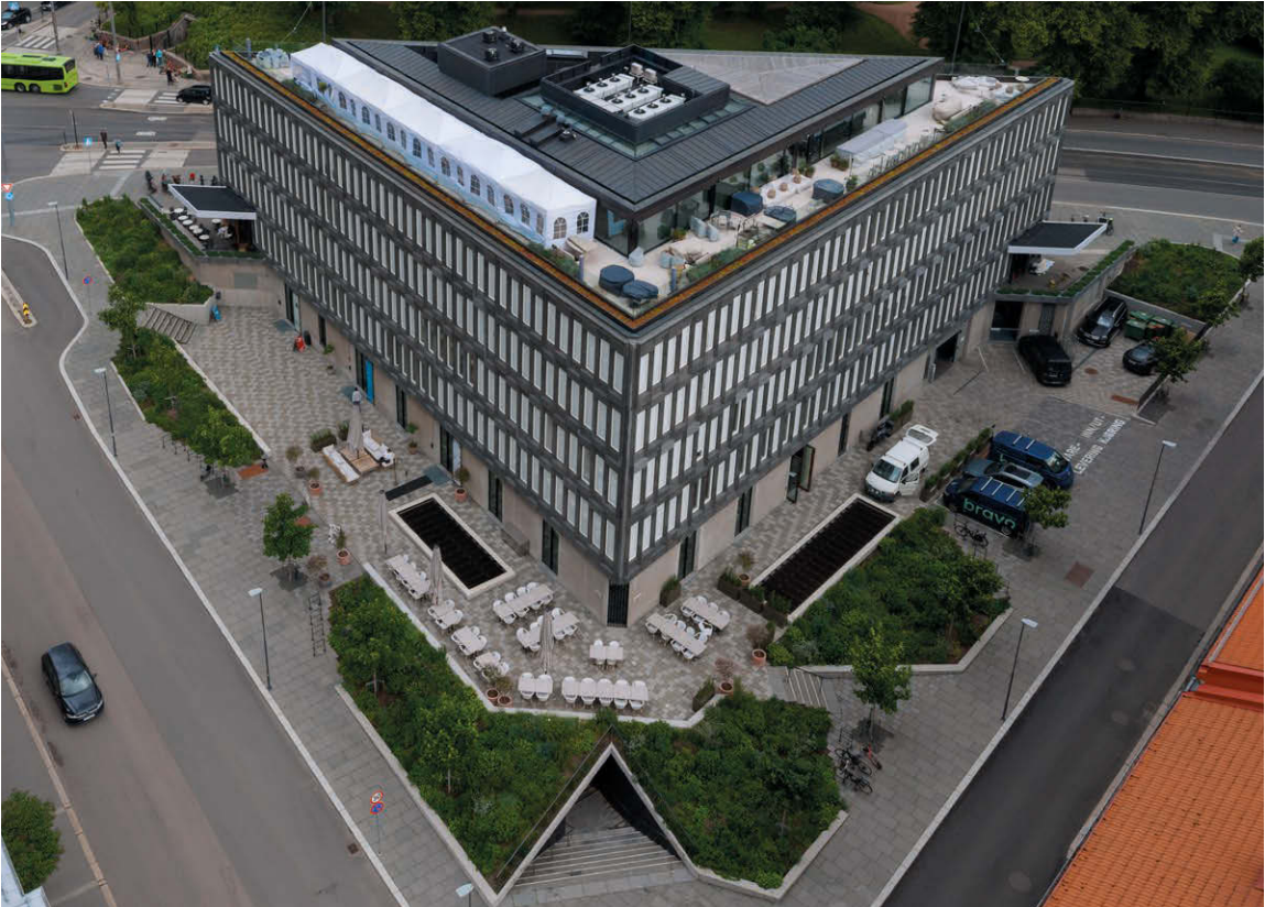
Durch die Verlegung der umfangreichen Haustechnik ins Untergeschoss wurde die oberste Ebene für ein Restaurant und Dachterrassen frei zugänglich.
