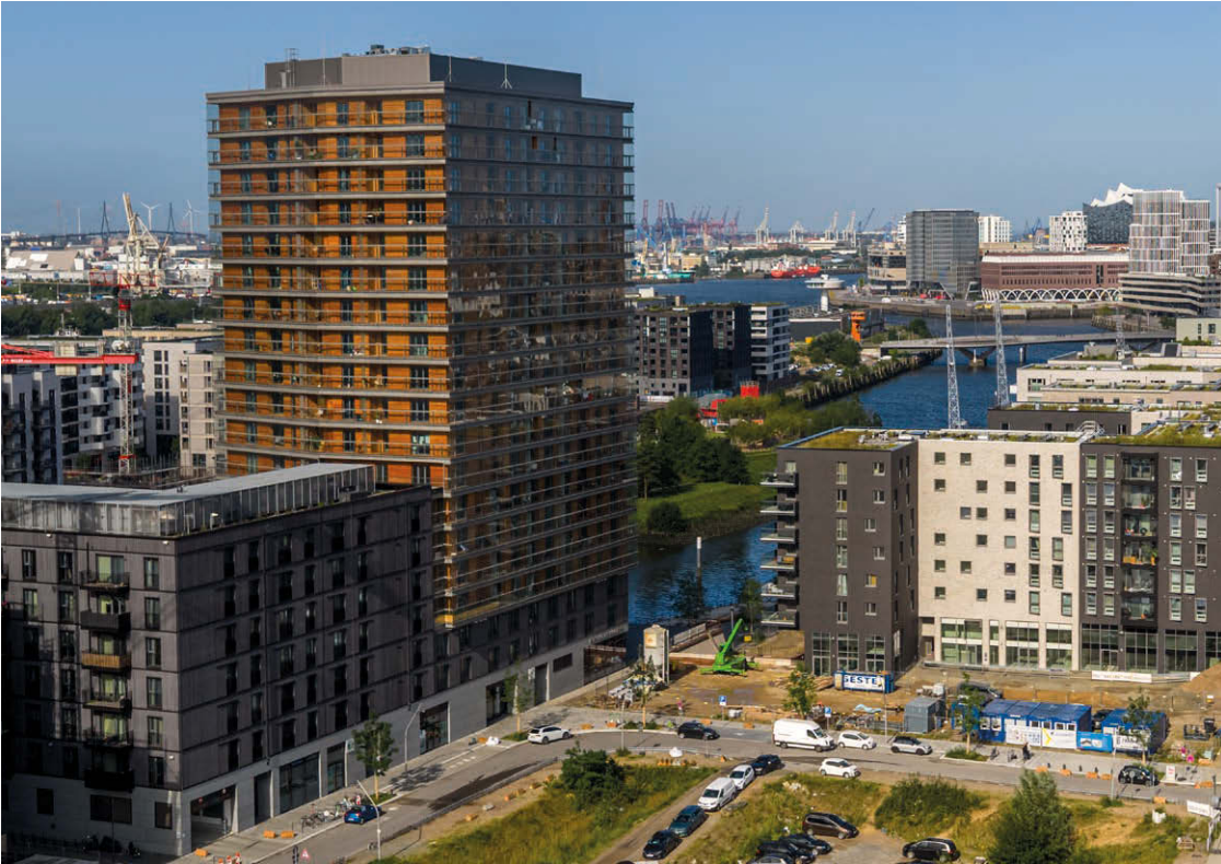
Hoch oben gibt es freien Blick über die Elbe bis zur Elbphilharmonie. Tief hinunter führen zwei Autoaufzüge zur Parkette im UG.
