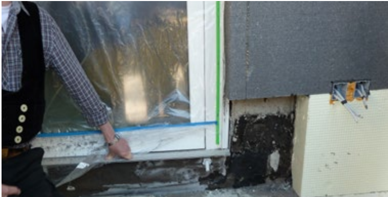
Nicht funktional: Abdichtungsversuch am Türanschluss mit einer Bitumendickbeschichtung. So nicht!
