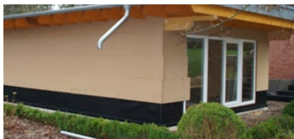
Abdichtung für Bodenplatte und Sockelbereich
