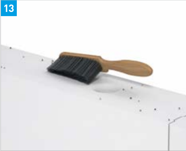
Steine vor dem Versetzen ober- und unterseitig abkehren
