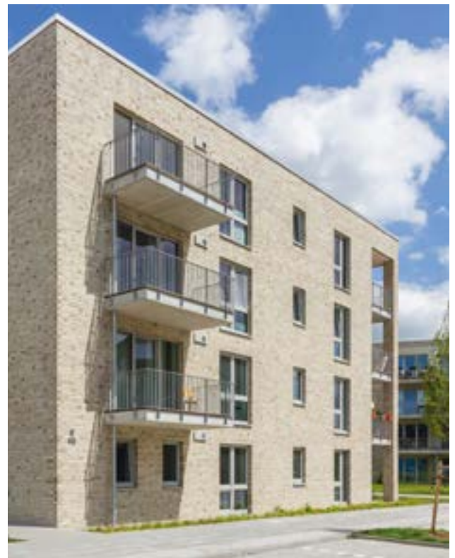
Großprojekt Mittlerer Landweg, Hamburg
