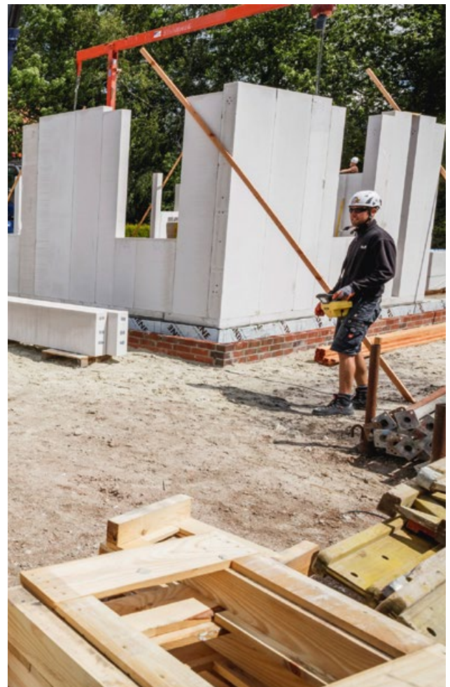
6 Jedes 4. Element mit Montagestütze sichern
