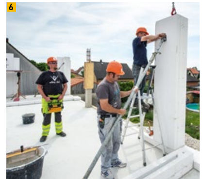
6 Jedes 4. Element mit Montagestütze sichern
