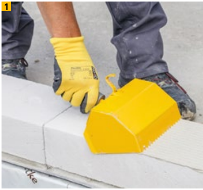
1 Ytong fix P Dünnbettmörtel vollflächig auf Ausgleichsschicht auftragen
