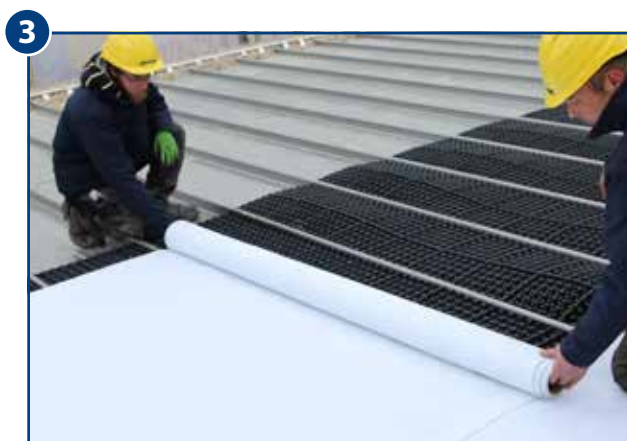
Vlies über das Urbanscape Drainage-System ausrollen.
