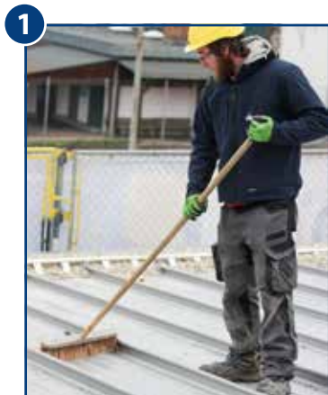
RIB-ROOF Dach besenrein säubern.
