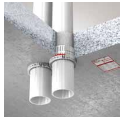
ZZ-Manschette in Massivdecke mit Nullabstand einseitig eingesetzt
