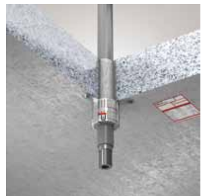
ZZ-Manschette in Massivdecke mit Mehrschichtverbundrohr einseitig aufgesetzt
