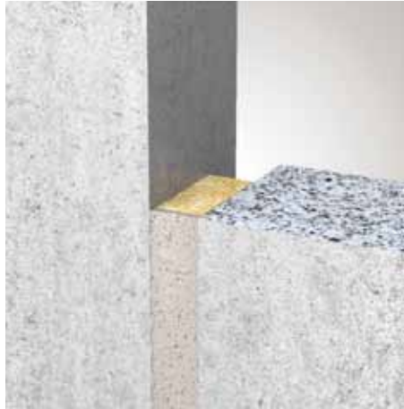
Lineare Brandschutzfugendichtung ZZ G30 mit Hinterfüllung durch Mineralwolle
