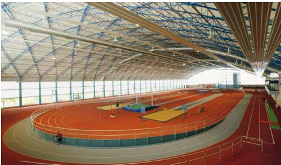
**Rekordverdächtig:** Dank der gleichmäßigen Temperaturverteilung über die gesamte Gebäudehöhe wird durch die Zehnder Heiz- und Kühldecken-Systeme eine optimale Behaglichkeit erzielt.
