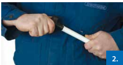
Abbildung 2: Kalibrierung und Entgraten des Rohres
