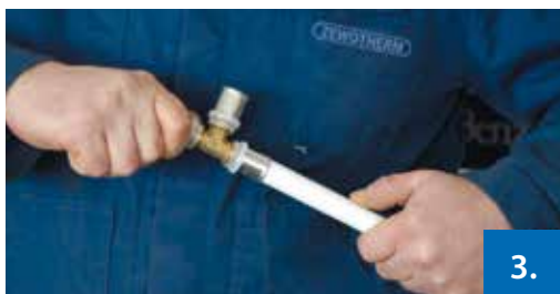
Abbildung 3: Einsetzen des Fittings
