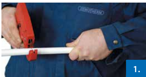
Abbildung 1: Ablängen des Rohres
