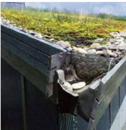
Abflussverzögerung einer extensiven Dachbegrünung
