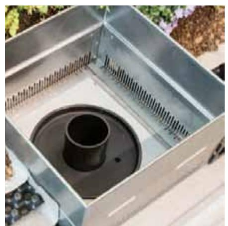
... bis ca. 80 l/m<sup>2</sup> temporärer Wasseranstau im Retentionsraum unterhalb einer Dachbegrünung
